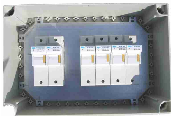
Z.B: 2x 80 A=Batterie u. 1x 125 A=USV
