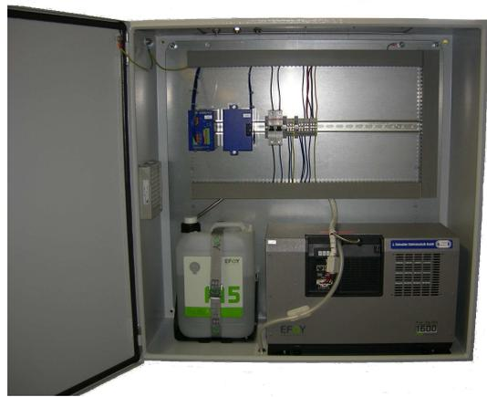
Die Brennstoffzellen Gleichstromversorgung der Typenreihe SF **AKKU**TEC arbeitet nach dem Bereitschafts-Parallel-Prinzip und gewährleistet, in Verbindung mit einem Bleiakkumulator und einer Tankpatrone, eine sichere Aufrechterhaltung der Gleichspannungsversorgung bei Netzausfall. Die Pufferzeit ist vom Ladezustand des Akkumulators und der Tankgröße, sowie dem Entladestrom abhängig
